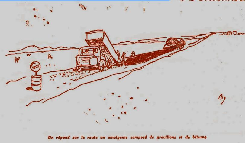
On répand sur la route un amalgame composé de gravillons et de bitume
