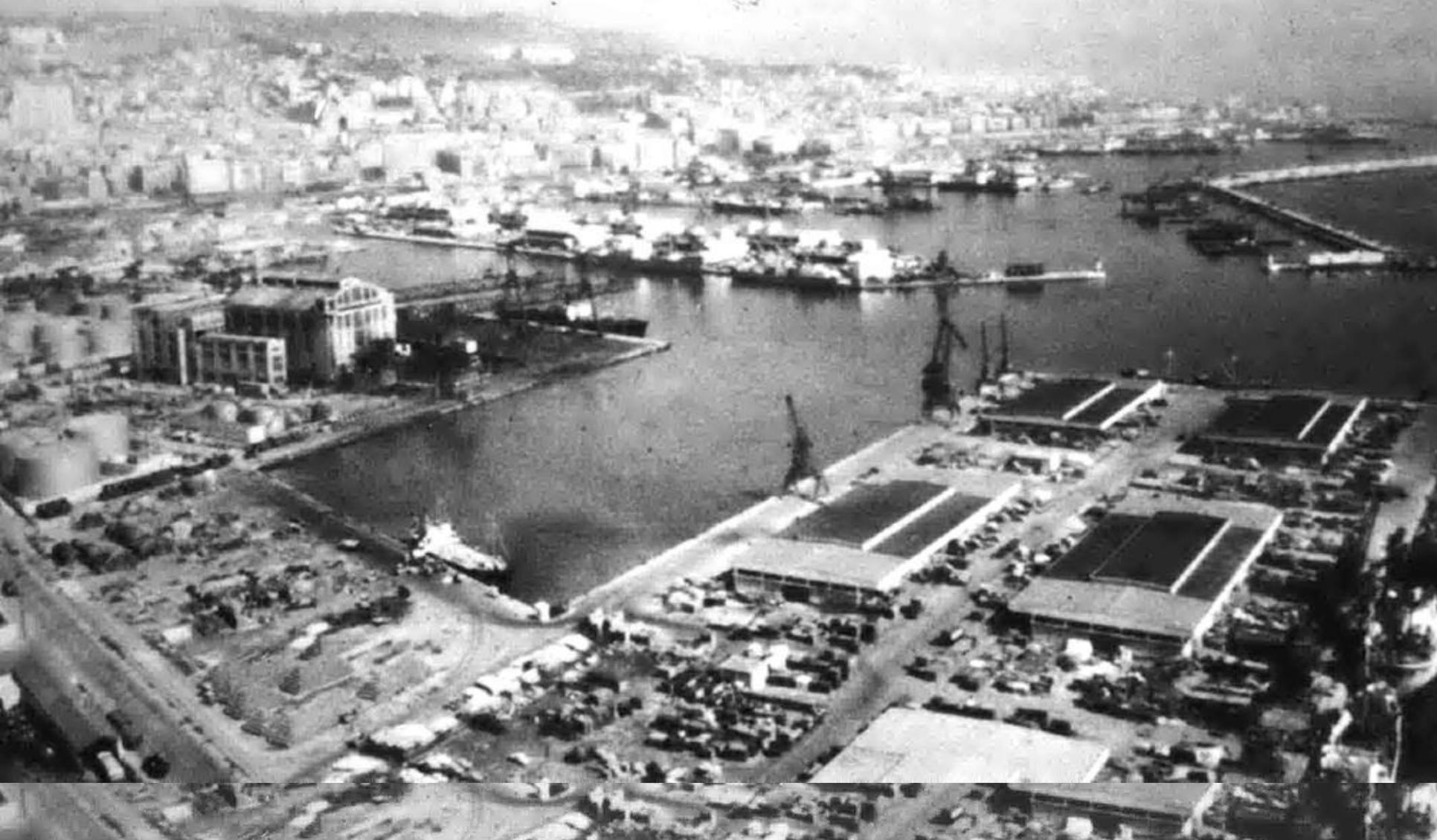
En 1960 le port d'Algiers se caractérisait par quelques chiffres : 8 km de quais, 205 ha de plan d'eau, plus de 6 km de jetées offrant aux navires 67 postes à quai, 82 000 m<sup>2</sup> de gare maritime, hangars et locaux divers. Dans le cadre national, le port d'Algiers se classait au sixième rang quant au tonnage total des marchandises embarquées ou débarquées.
