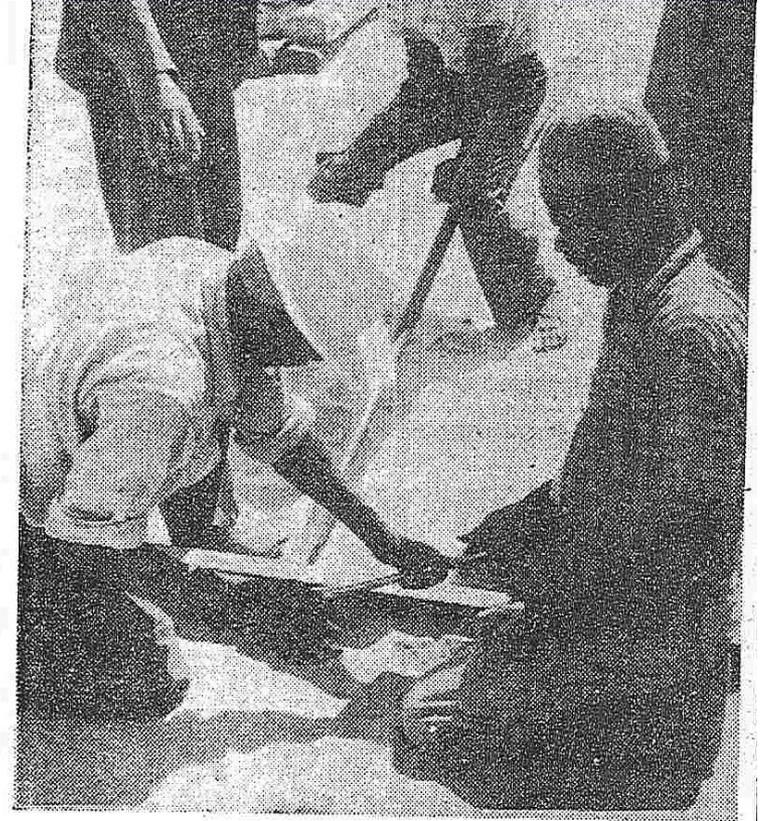
*Le rail neuf vient d'être posé. On boulonne les éclisses*
