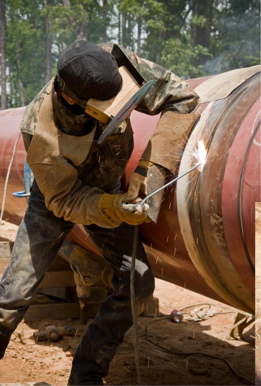
Je suis réveillé par le bruit lancinant de roulette le dentiste de l'énorme machine du *double jointing* . C'est une opération qui consiste pour gagner du temps à doubler par soudure la longueur des tubes en les assemblant par soudure en deux éléments de 12 m soit 24 m, avant leur transport .
