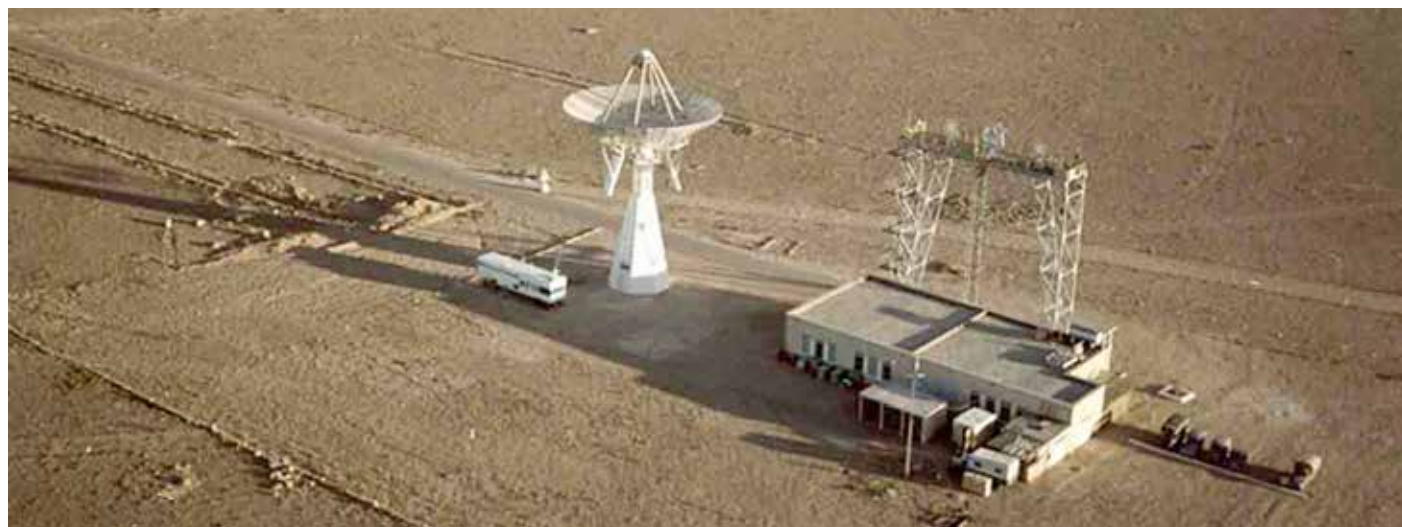
▲ La station de télémesure avec l'antenne géante Cyclope qui pèse 35 tonnes et mesure 27 mètres de hauteur ▼ Radars de suivi
