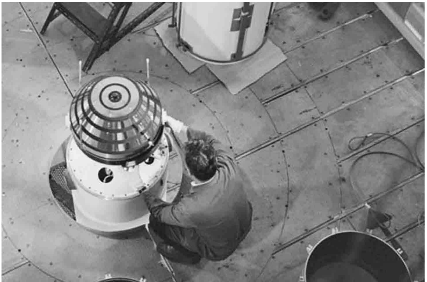
▼ Montage du satellite Astérix au Centre d'Achèvement des Propulseurs et des Engins (CAPE) de Saint-Médard-en-Jalles
