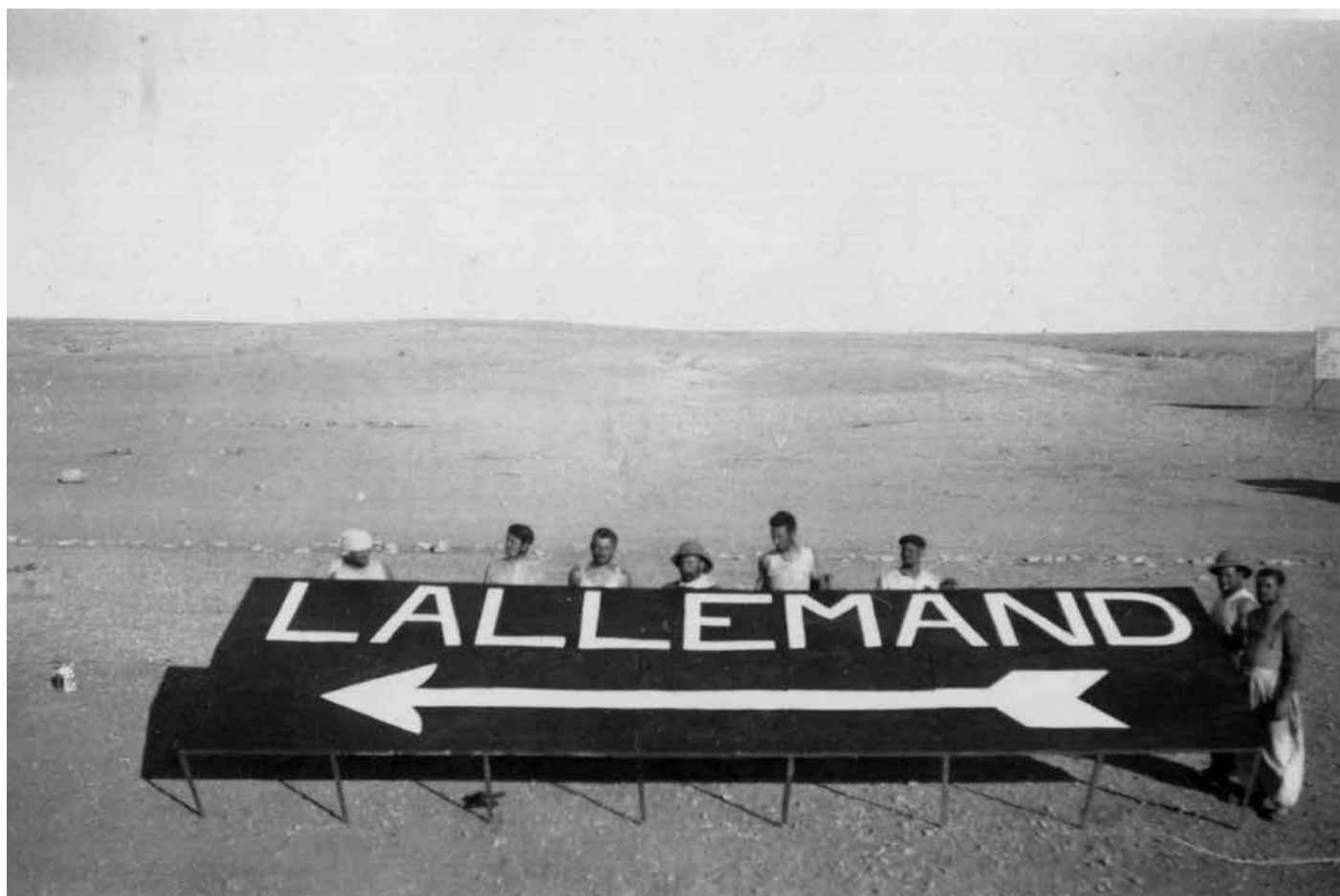
▲ Pose d'un panneau indicateur
