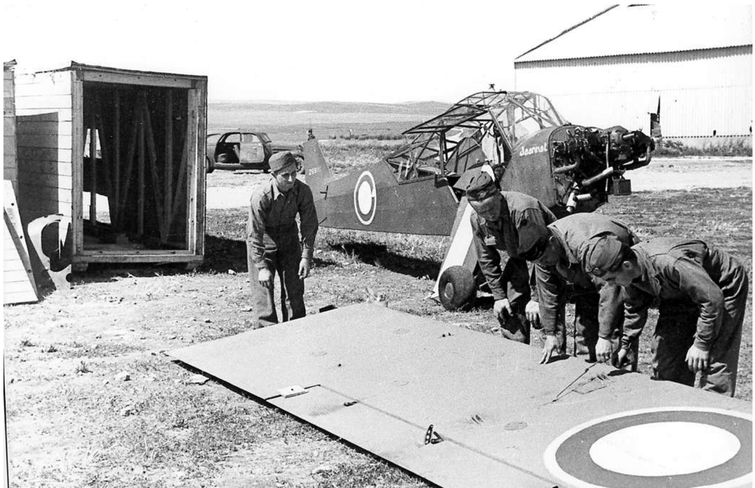
Remontage d'un Piper Cub arrivé en caisse des États-Unis via la base de transit d'Oran-la-Sénia. L'appareil est le L-4 serial 43-29911 baptisé "Jeannot" qui sera affecté à la 25 e section de la 2 e DB et survolera Paris à la Libération pour porter un message à la Préfecture de Police (photo ECPA, via Pierre Jarrige)..
